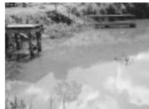
Captação de água.
